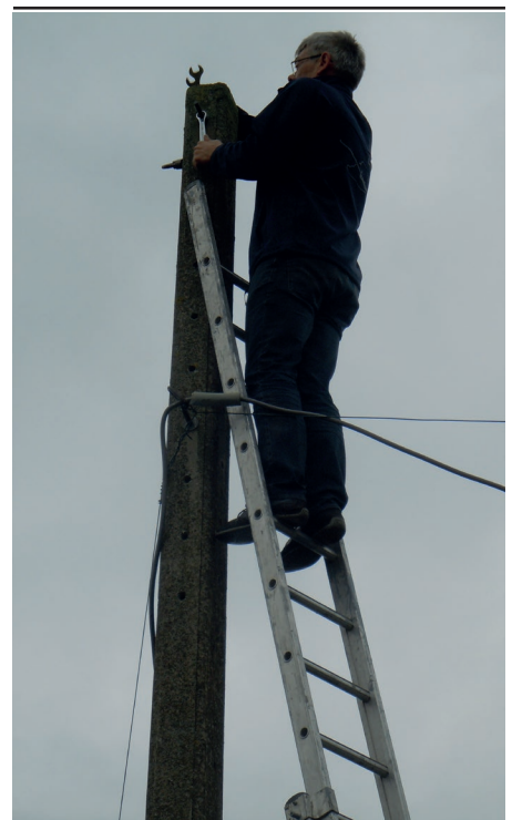
Yves spant de nieuwe kabel van het clublokaal naar de hangars
